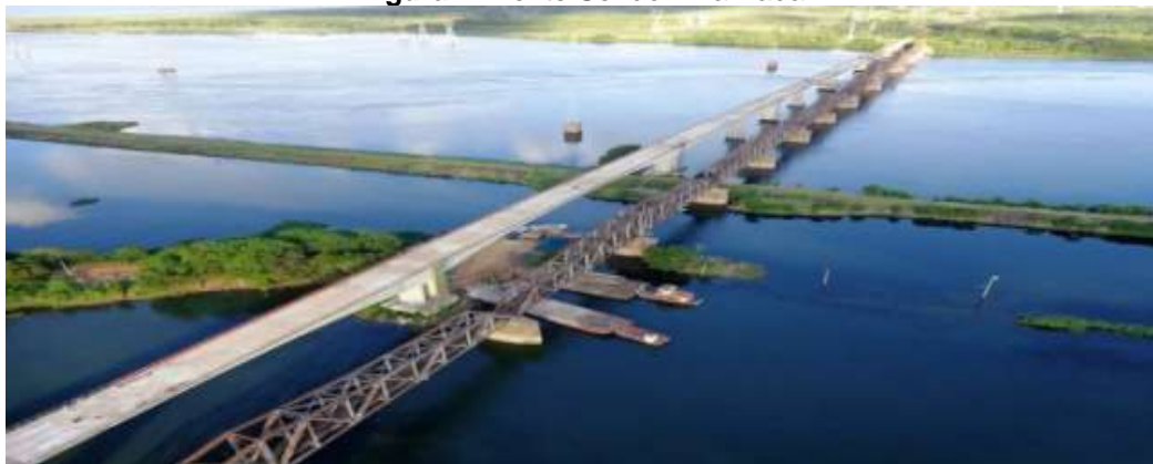
Figura 1: Ponte Sendo Finalizada
