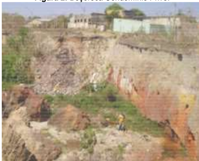
Figura 2: Boçoroca Condomínio Prive.
