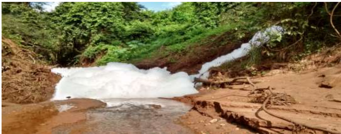
Figura 3: Ponto de lançamento do efluente.
