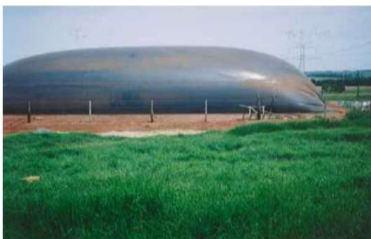
Figura 2: Biodigestor modelo canadense
