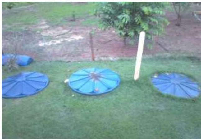
Figura 7: Biodigestor Tipo Fossa Séptica
