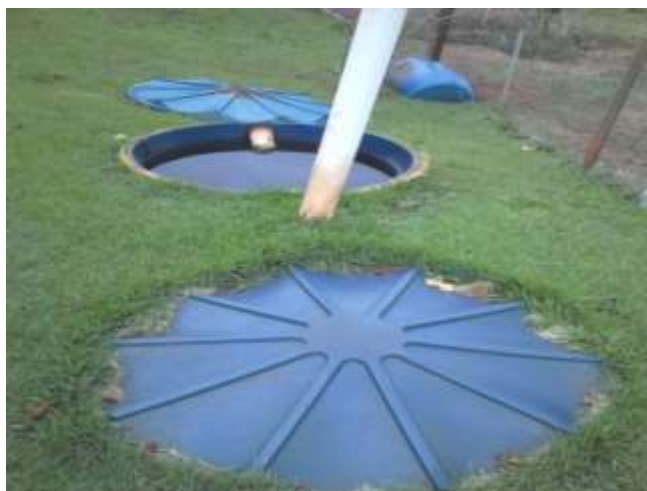
Figura 8: Biodigestor Tipo Fossa Séptica
