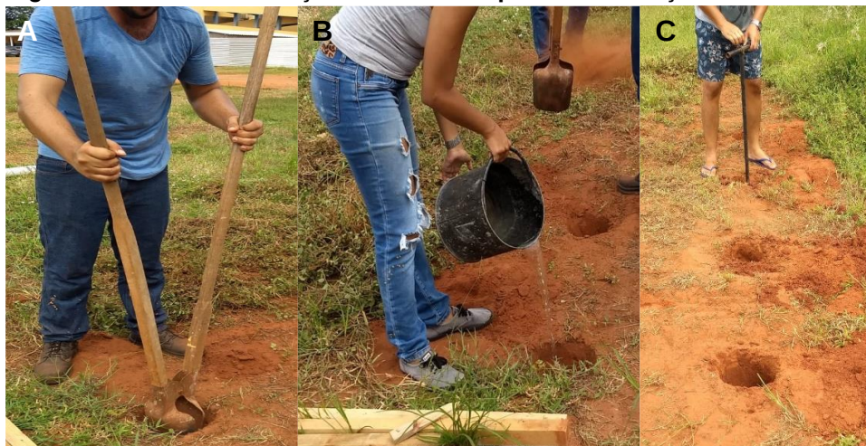
Figura 2. Início da escavação dos buracos para a construção do telhado.
