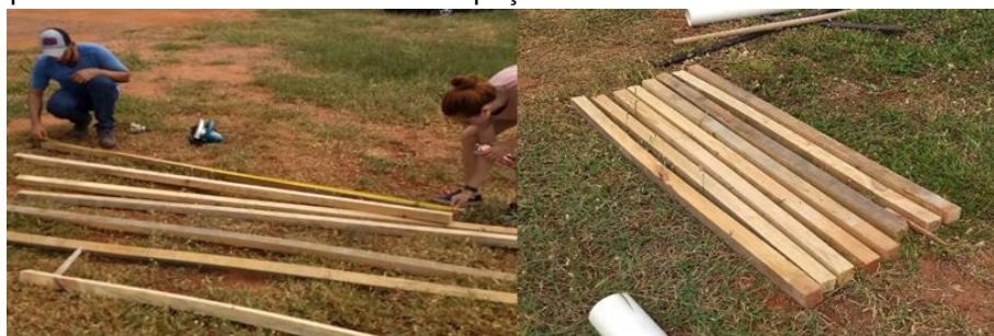
Figura 3. Estacas de madeiras sendo cortadas com uso de cerra elétrica para manter-se a uniformidade nas peças.
