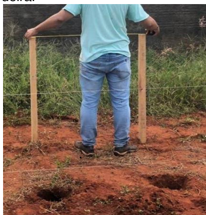
Figura 4. Demarcação para nivelamento das ripas de madeira.
