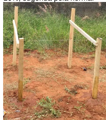
Figura 5. Ripas de madeira colocadas em inclinação de 10%, sugerida pela norma.
