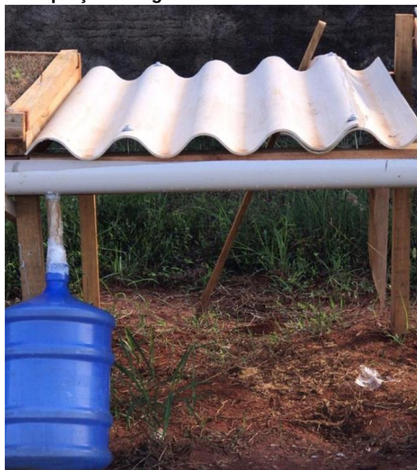
Figura 6. Telhado com telha Eternit (fibrocimento), finalizado com todo o esquema de captação de água. Medidas: 1x1x1.
