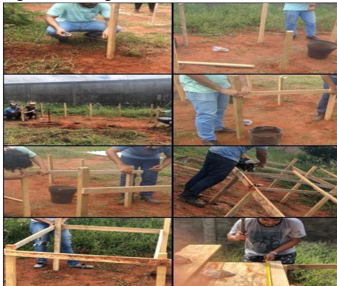
Figura 4. Montagem da estrutura.
