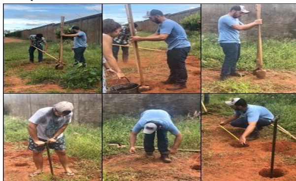
Figura 3. Preparação do terreno para montagem do aparato.
