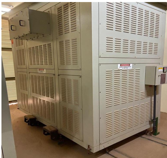
Figura 12. Transformador defasador para uso no MVW3000.
