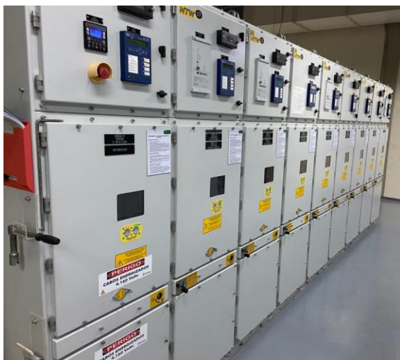
Figura 11. Cubículo alimentador do MVW3000.
