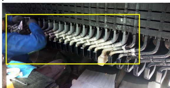
Figura 3. Processo de isolamento (em destaque) elétrico das bobinas do estator no lado acoplado.
