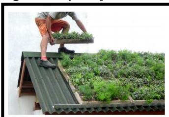
Figura 2. Aplicação dos módulos prontos no telhado.
