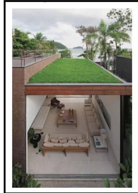
Figura 1. Modelo de teto verde contínuo.
