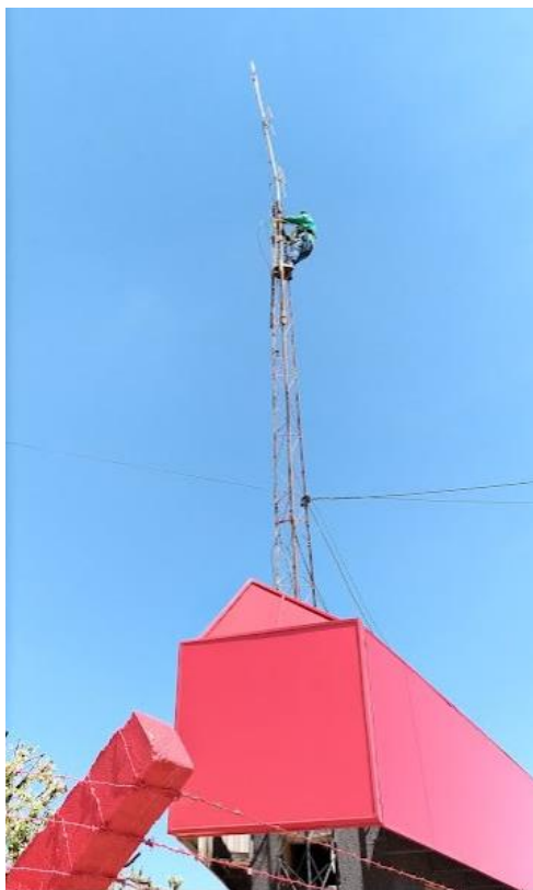
Figura 1. Instalação da antena digital. A evolução da transmissão da era digital da Rádio Difusora, saindo do AM indo para o FM com a nova antena transmissora de sinal.
