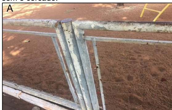
Figura 3. Falta de segurança no parque infantil. A. Estrutura metálica enferrujada. B. Portão sem o cercado.
