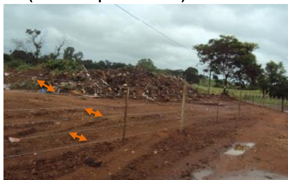
Figura 2. Isolamento do Ecoponto com arame liso (indicados pelas flechas).
