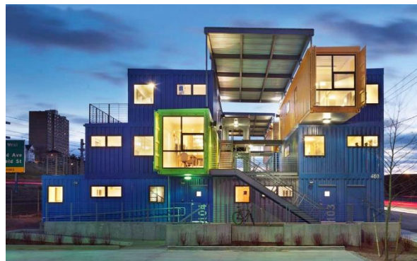
Figura 8. Construção feita a base de containers.
