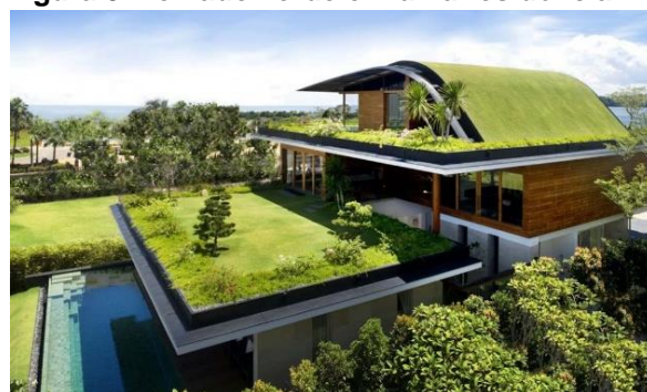
Figura 5. Telhado verde em uma residência.
