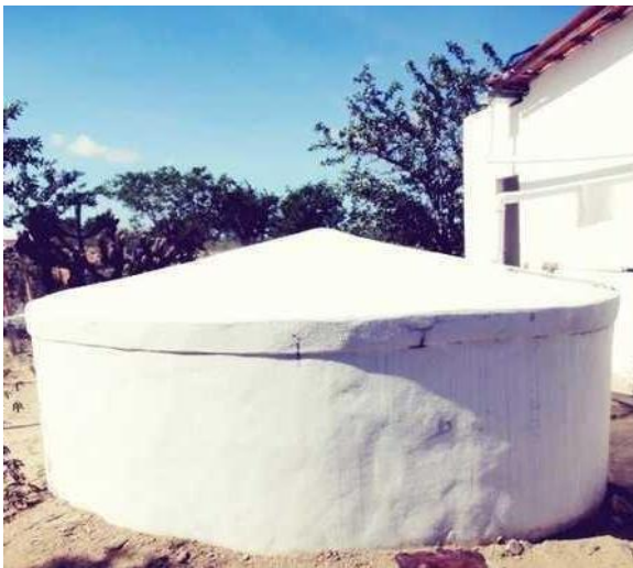
Figura 1. Cisterna de Alvenaria.
