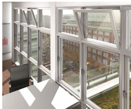
Figura 3: Esquadrias para ventilação.
