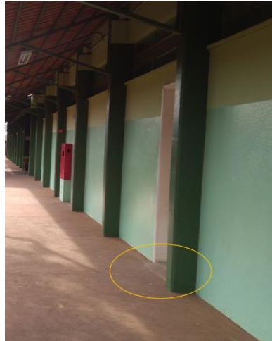
Figura 3. Nivelamento do acesso à sala de aula da escola analisada.
