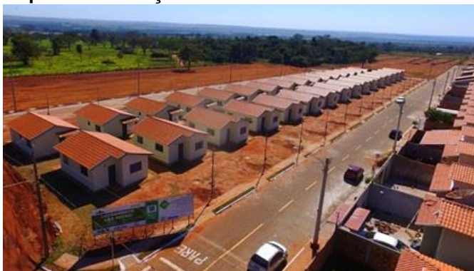
Figura 7. Habitação de Interesse Social concluídas, contendo rampas para cadeirantes somente nas esquinas das calçadas.
