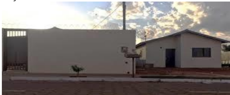
Figura 6. Habitação de interesse social construída, sem calçada.
