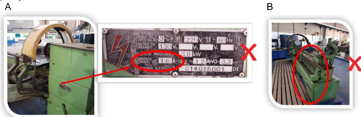
Figura 1. Componentes de partida, parada, acionamento e controles do torno carcaceiro (NDT 650/1981). A. Alto valor da corrente e não presença de dispositivo de segurança. B. Parte móvel sem proteção fixa.
