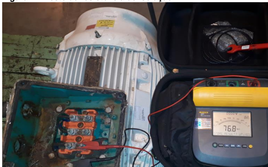
Figura 11. Teste de resistência de isolação.
