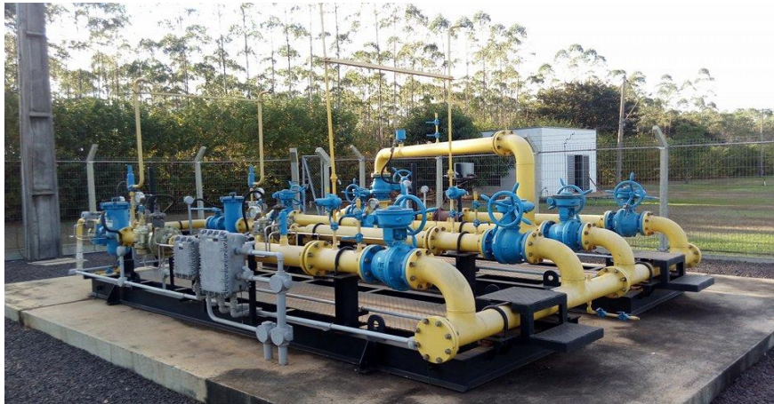
Figura 7. Estrutura metálica protegida da oxidação devido a proteção catódica.
