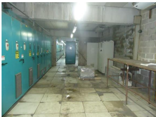
Figura 1. Sala de painéis em sua condição atual usada para inspeção e adequação (2018).
