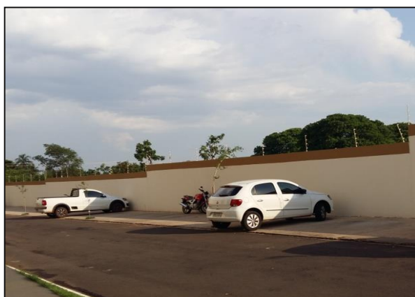
Figura 7: Estacionamento sem cobertura. Fonte: Nathália Dias, out, 2015.
