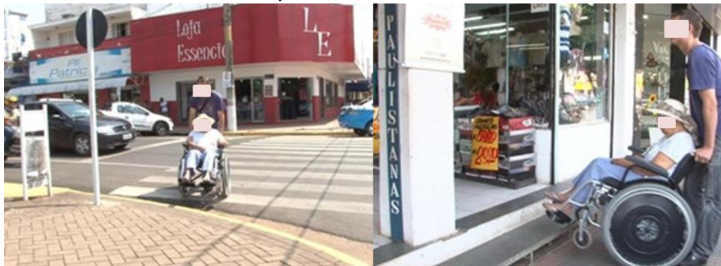
Figura 4. Acessibilidade precária nas vias públicas da cidade de Três Lagoas. A. Ausência de rampa para cadeira de rodas na calçada. B. Ausência de rampa para cadeira de rodas na entrada da loja.
