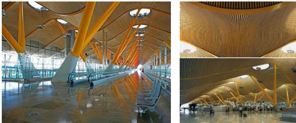
Figura 4. Telhado do terminal T4 do Aeroporto Barajas (Madrid, Espanha).
