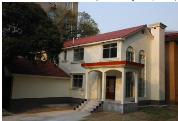
Figura 5. Casa construída com bambu na Universidade Hunan, campus Changsha (China).
