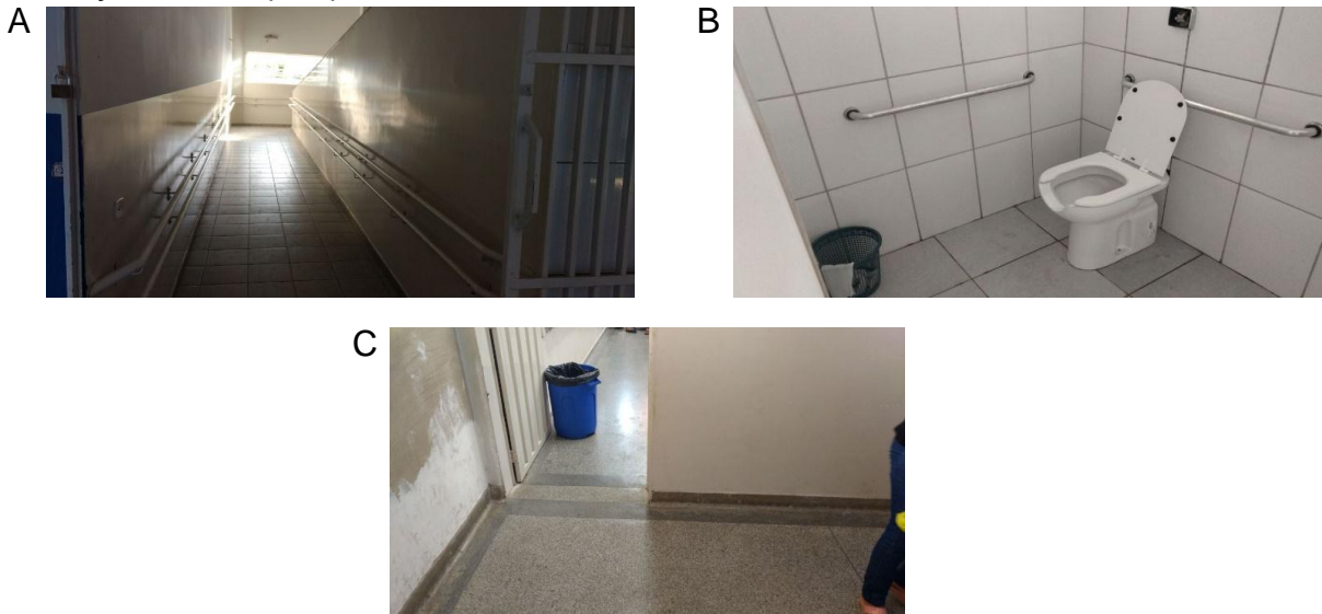
Figura 1. Condições de acessibilidade na escola pública municipal em estudo. A. Rampa acessível a cadeirantes e com corrimãos, porém sem elementos antiderrapantes. B. Banheiro para deficientes com barra de apoio para cadeirantes e assentos sanitários especiais. C. Falta de sinalização tátil e de piso para deficiente visual.
