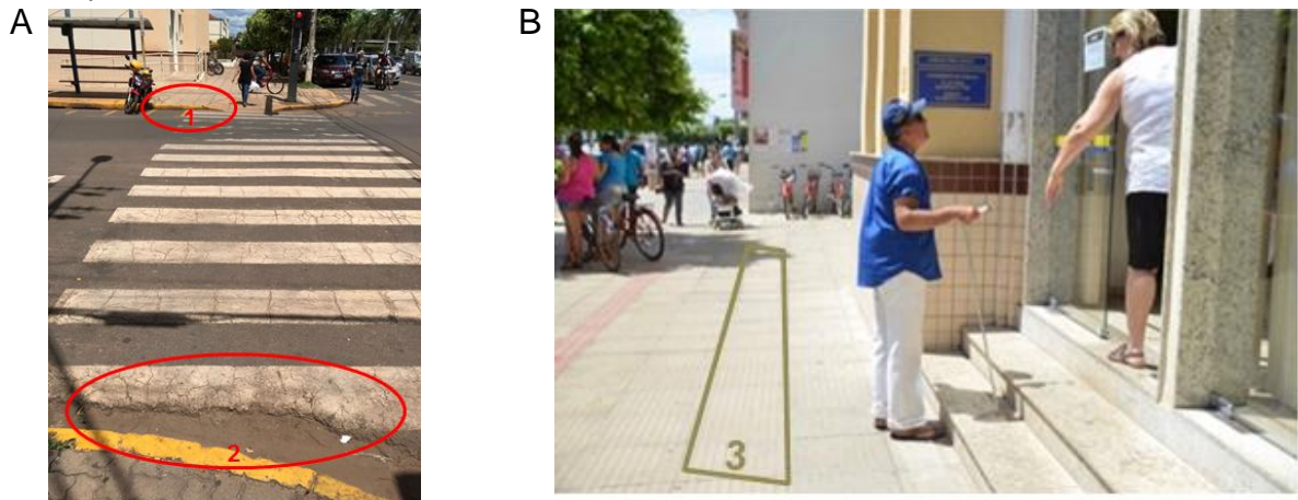
Figura 1. Problemas quanto à acessibilidade nas ruas centrais da cidade de Três Lagoas, MS. A.1 Presença de rampa em uma das extremidades da faixa de pedestre. A.2 Ausência de rampa na outra extremidade da faixa de pedestre, além do desnível no asfalto. B.3 Ausência de piso com alto relevo para direcionar o deficiente visual.
