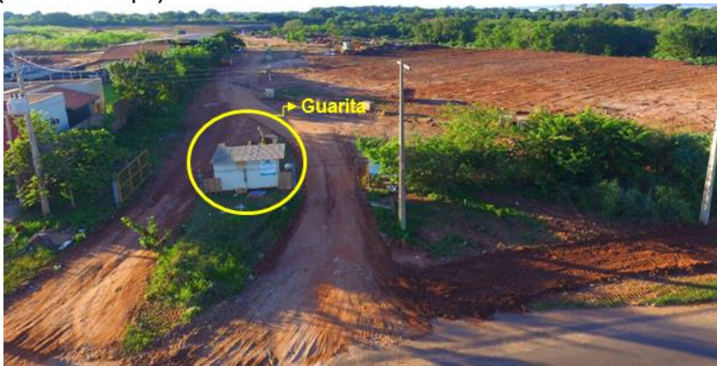
Figura 2. Guarita de fiscalização de veículos na entrada de despejo de RCC (Buracão do Júpia).
