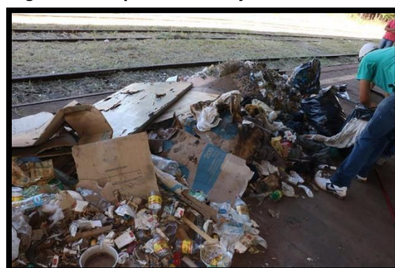
Figura 6. Limpeza da Estação.
