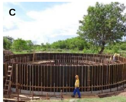
Figura 6. ETE Jupiá. A. Figura 17 – Reator Anaeróbio de Leito Fluidizado. B. Biodiscos. C. RALF em construção.
