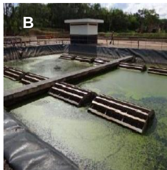
Figura 6. ETE Jupiá. A. Figura 17 – Reator Anaeróbio de Leito Fluidizado. B. Biodiscos. C. RALF em construção.
