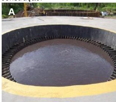
Figura 6. ETE Jupiá. A. Figura 17 – Reator Anaeróbio de Leito Fluidizado. B. Biodiscos. C. RALF em construção.
