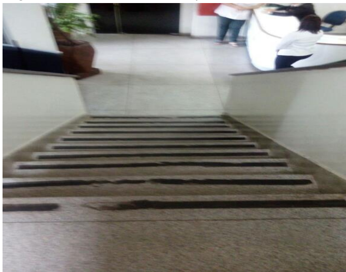
Figura 9. Vista 3 da escada do prédio em estudo.
