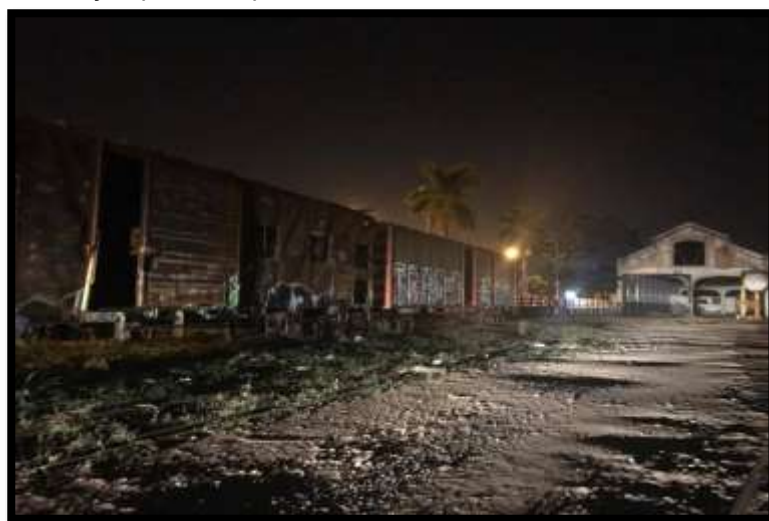
Figura 4. Estação Ferroviária de Três Lagoas/MS abandonada e totalmente escura. Houve necessidade de iluminação presente para se tirar foto.
