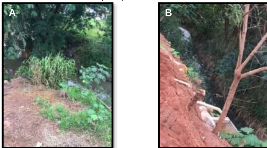
Figura 6. Sinalização ineficiente às margens do Córrego da Onça. A. Ausência de barreira de proteção. B. Ausência de mata ciliar.
