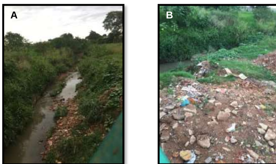
FIGURA 5. Situação de descuido em que o Córrego da Onça se encontra. A. Assoreamento e erosão da margem do córrego. B. Lixo e entulhos.
