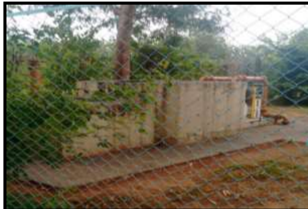
Figura 8. Estação de tratamento da empresa SANESUL.
