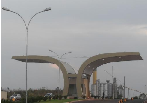
Fig.03- Estrutura pronta (fonte - Mirian A. S - 2012)
