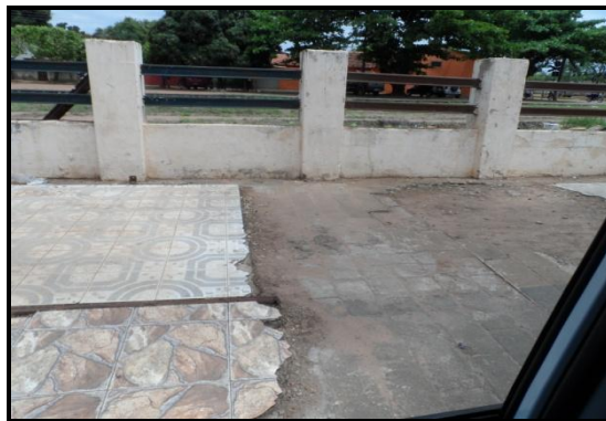
Figura 11: Detalhe da calçada. Fonte: Vanessa Barroso, out, 2013.
