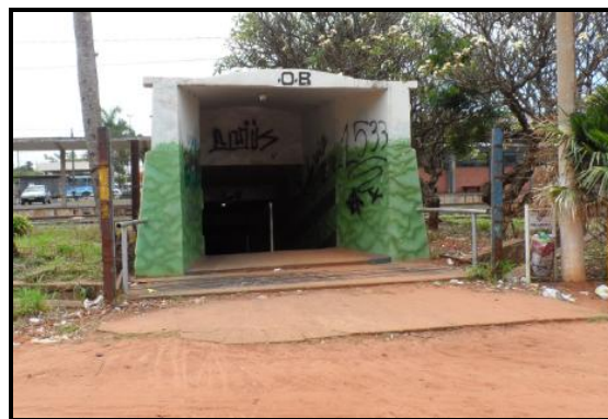
Figura 7: Túnel de acesso para pedestres. Fonte: Vanessa Barroso, out, 2013.
