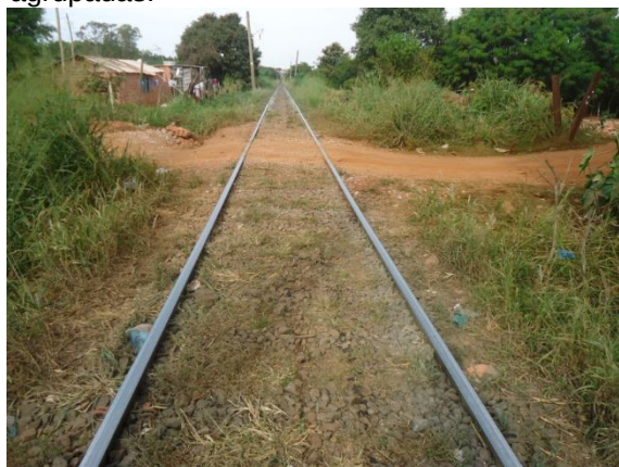
Figura 4. Impacto no lastro ferroviário decorrente de interferências externas agrupadas.
