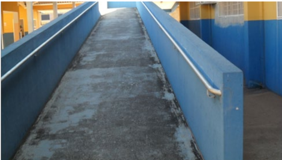
Foto 1: Rampa de Acesso ao Anfiteatro
