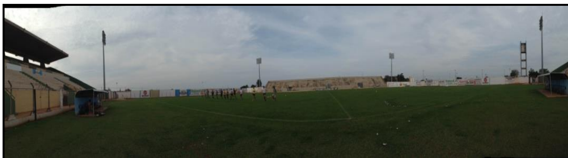
Figura 3: Estádio com os pontos de iluminação já instalados. Fonte: Raphaela Pires Sato, set., 2014.
