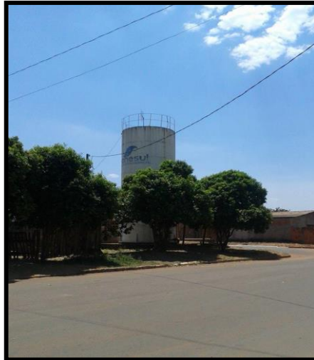
Figura 5: Caixa d'água distribuidora. Fonte: Anyara Fernandes, out., 2014.
