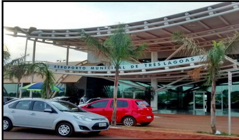
Figura 1: Aeroporto Plínio Alarcom. Fonte: Mariana Freitas Vieira, set., 2014.
