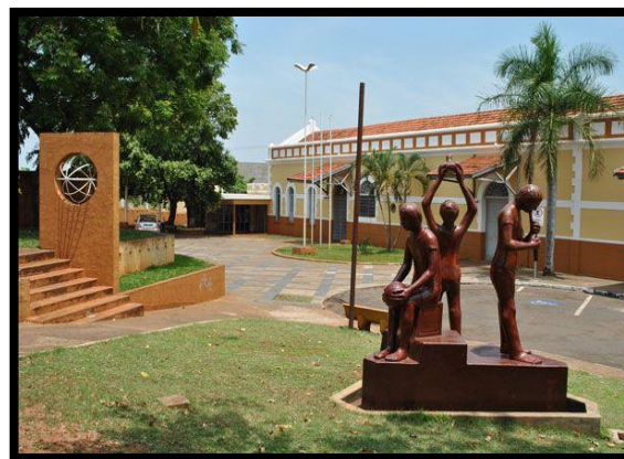
Figura 7: Estação Ferroviária. Fonte: Aline Carreira, out. 2014.
