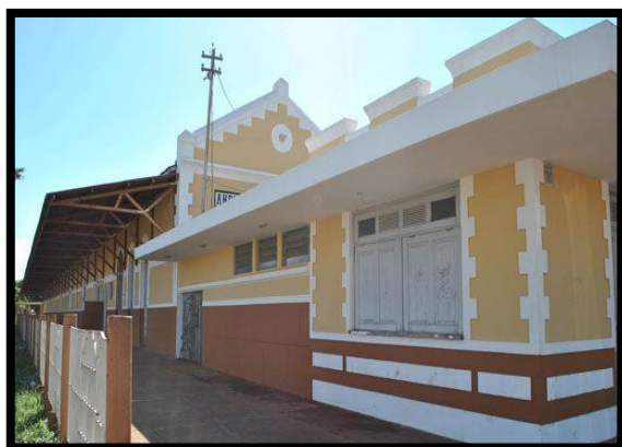
Figura 6: Estação Ferroviária. Fonte: Aline Carreira, out. 2014.
