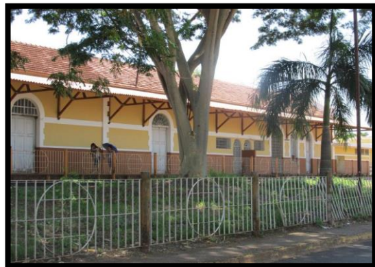
Figura 5: Estação Ferroviária em 2014. Fonte: Odílio Pereira de Queiroz Neto, 2014.
